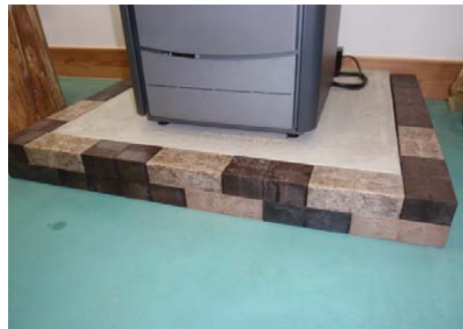
【ストーブ台】 コンクリートの台周囲をレンブロックで飾っています。
